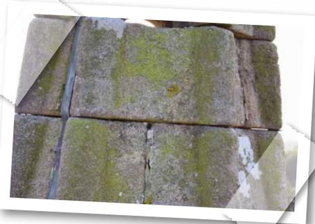
Sur la partie supérieure du clocher les pierres sont déjointes et le ciment s'effrite.
