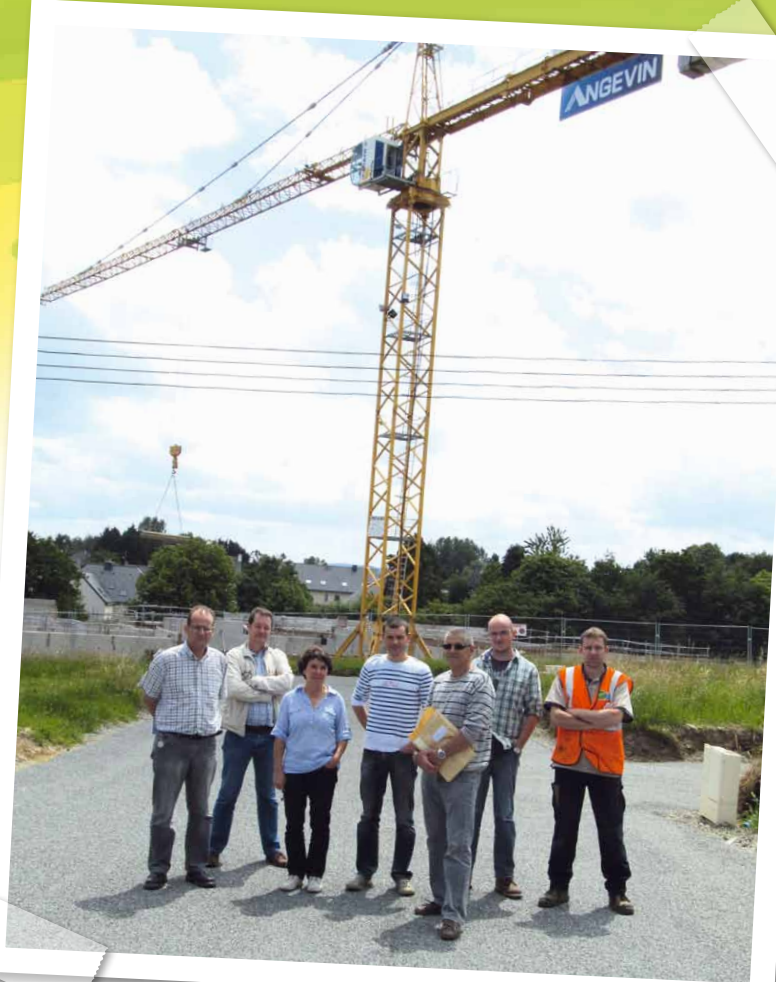
La réception des travaux de réseaux à Anjela Duval
